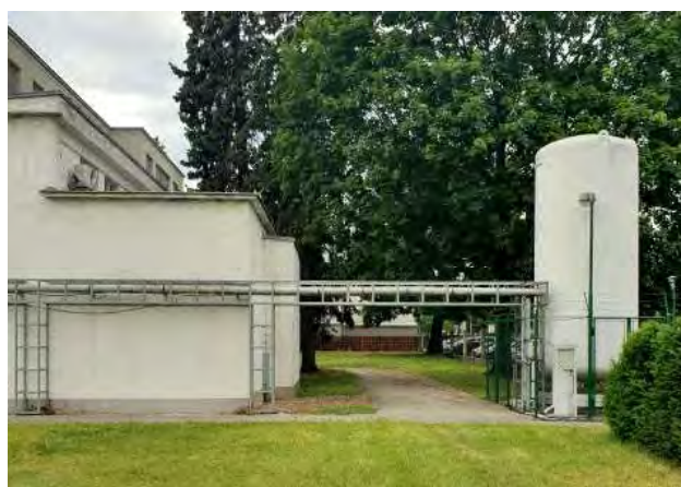
Рис. 27. З'єднання кріобанку з резервуаром для зберігання рідкого азоту за допомогою ізолюваного трубопроводу.
